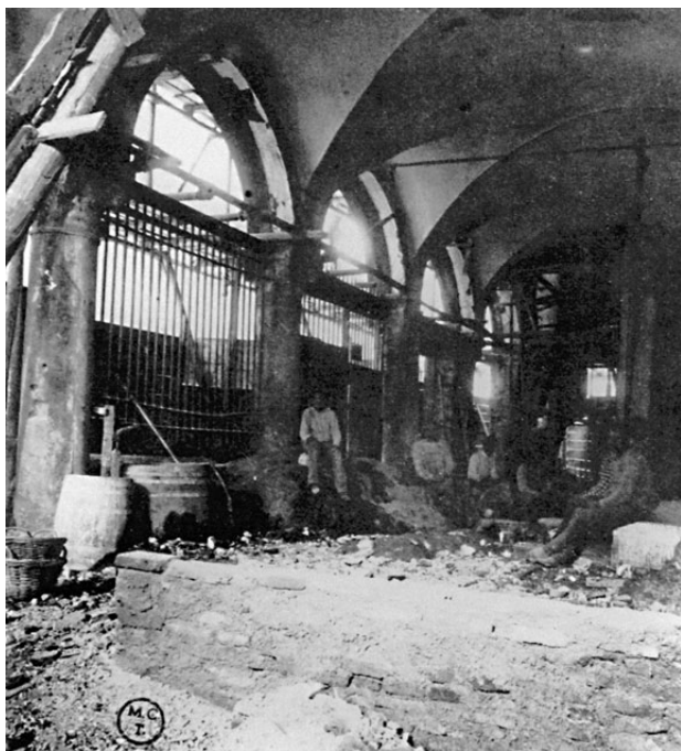
Fig. 2 – Palazzo San Giorgio. Interno del portico prima del restauro del 1892 (foto da Museo Civico di Torino, fondo D’Andrade): sono visibili le volte successivamente demolite e le colonne rinascimentali tuttora in posto.
