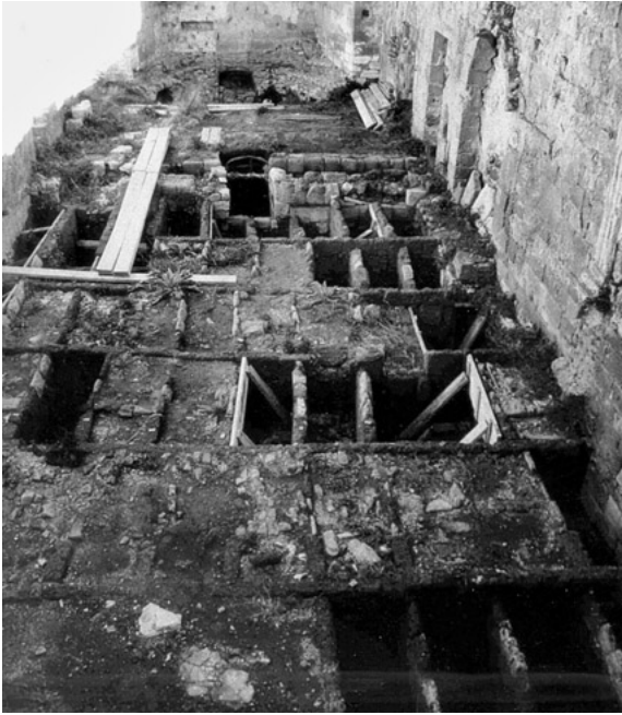
Fig. 1 – Sovana, interno della chiesa di San Mamiliano prima degli scavi del 2004.
