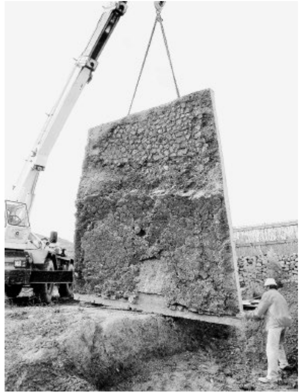
fig. 4 – Teramo, operazione di distacco di una delle grandi porzioni murarie rinvenute sui livelli di obliterazione del tempio post-sisma; la grande porzione di circa 3 m di altezza è stata sollevata con una potente gru messa a disposizione dalla società appaltatrice dei lavori stradali ANAS.
