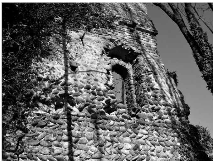
Fig. 4. Fortificazioni di Rado (Gattinara): dettaglio della muratura in ciottoli fluviali della torre. Foto E. Destefanis.
