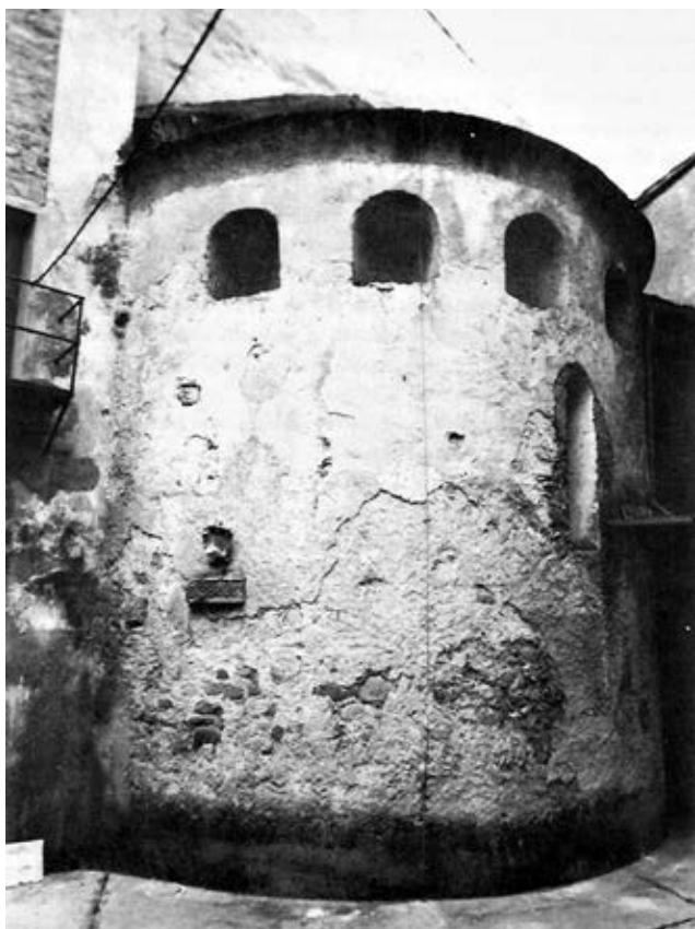
Abside prima del restauro
