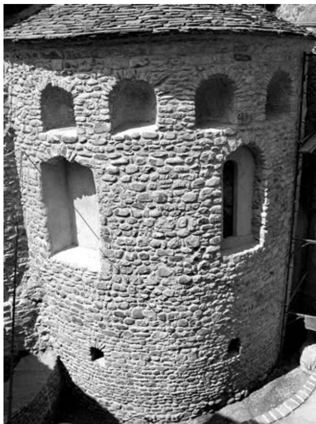
Abside dopo il restauro
