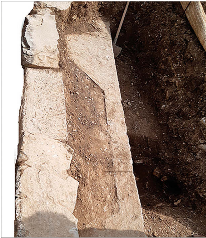
Fig. 4 – Sesto Fiorentino (FI). Muro e drenaggio nella parete di destra del dromos esterno, rispondente al disegno di fig. 3, osservato in occasione dei recenti lavori realizzati nel 2020-2021 (foto P. Pallecchi).
