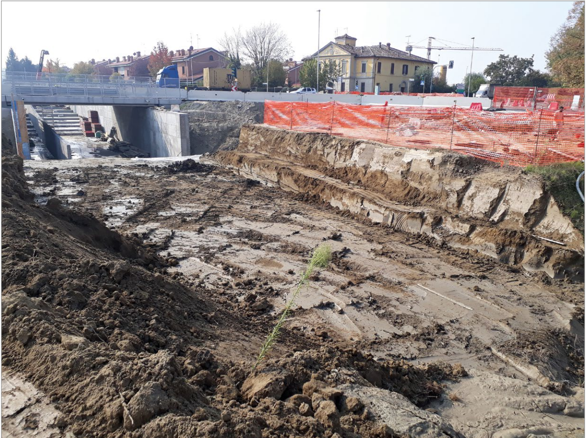
fig. 2 – Panoramica degli scavi per la realizzazione del nuovo sottopasso di Funo (foto Città Metropolitana di Bologna).
