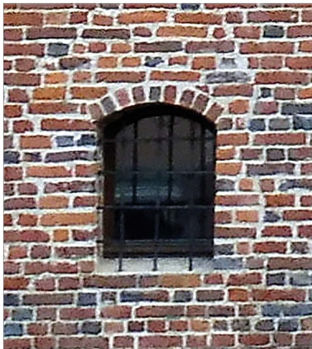
Fig. 147 – Prospetto nord: monofora con ghiera semplice.
