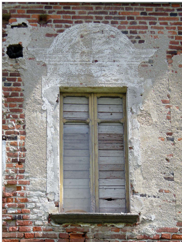
Fig. 155 – Prospetto ovest: finestra rettangolare con fasce perimetrali intonacate e decorazione graffita.
