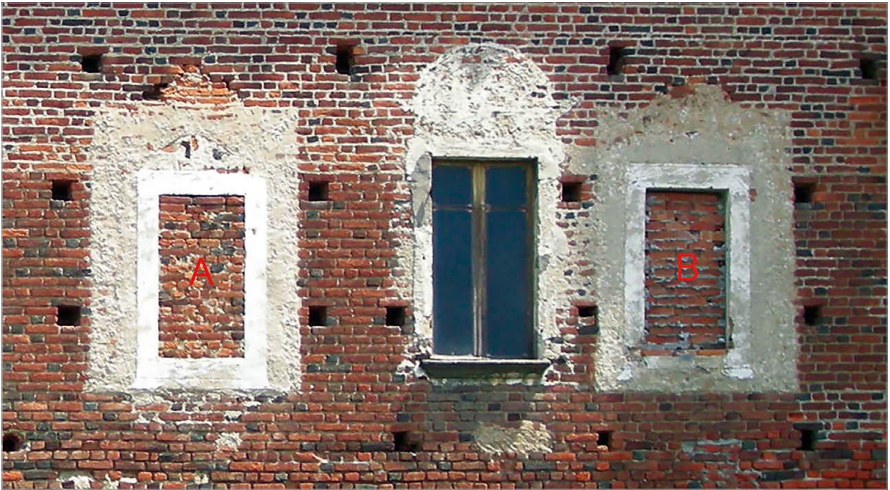
Fig. 167 – Prospetto ovest: finestre rettangolari con tamponatura di precedenti monofore ogivali.
