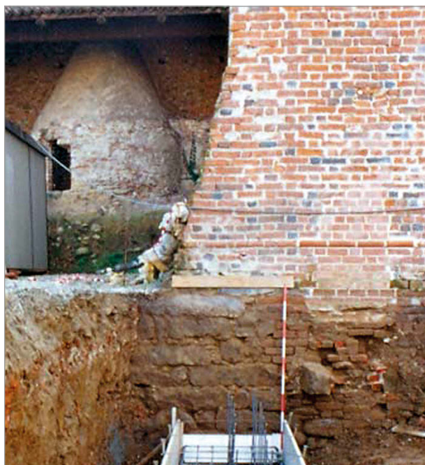
Fig. 25 – 2006-2007: perimetrale nord, da nord.
