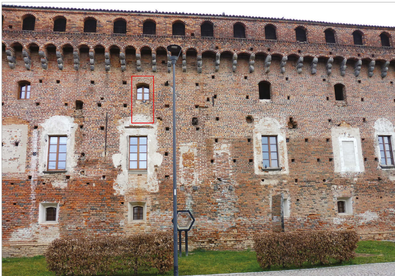
Fig. 162 – Prospetto ovest: nel dettaglio apertura a sesto ribassato (ora tamponata) funzionale all'accesso al ballatoio ligneo di cui si conservano porzioni delle mensole di appoggio.
