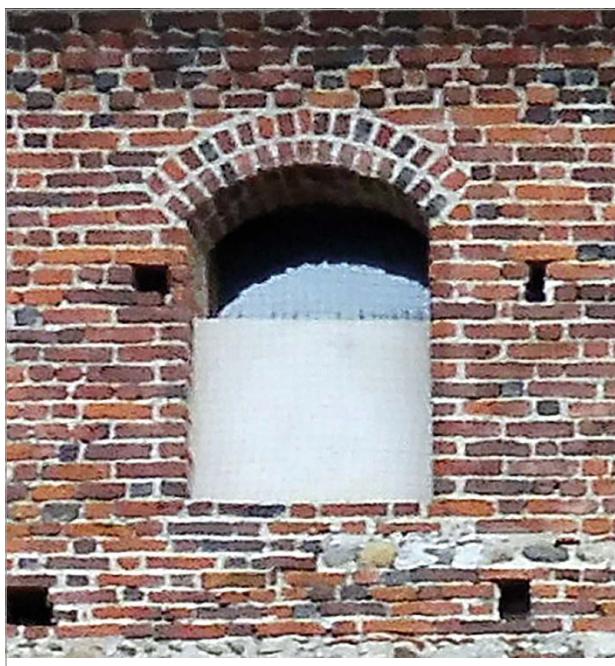
Fig. 148 – Prospetto nord: monofora con ghiera doppia.
