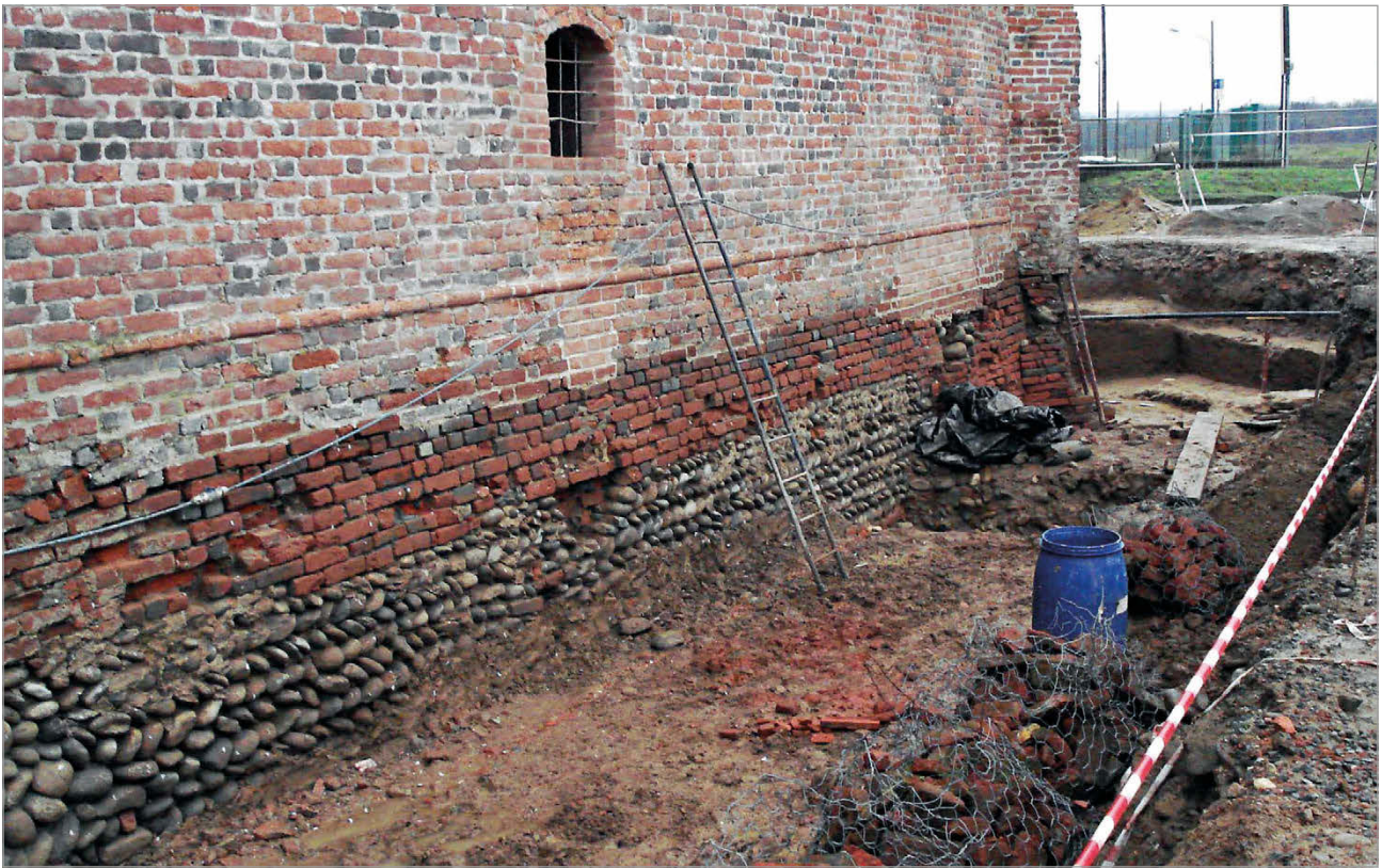
Fig. 23 – 2006-2007: perimetrale del castello durante i lavori.
