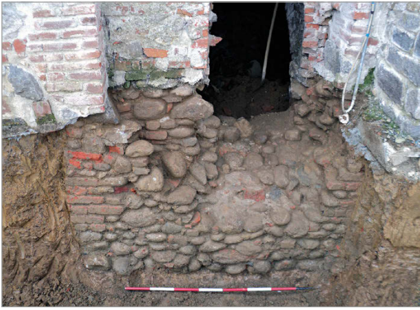
Fig. 50 – 2016: particolare fondazione c/o apertura ovest, da nord.
