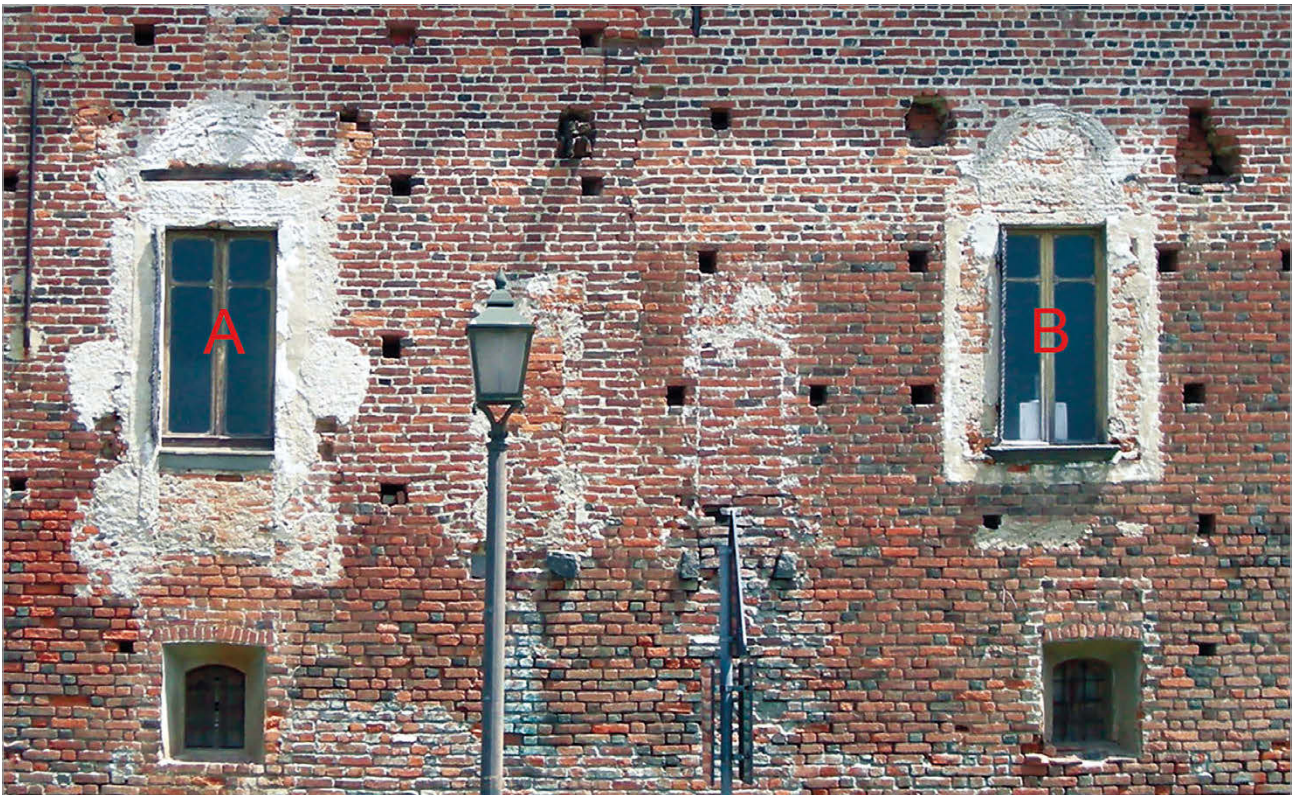
Fig. 168 – Prospetto ovest: attuale finestra rettangolare realizzata ridimensionando una precedente finestra con cornice fittile modanata (B) e finestra sormontata da travetto ligneo per consolidare la struttura muraria (A).
