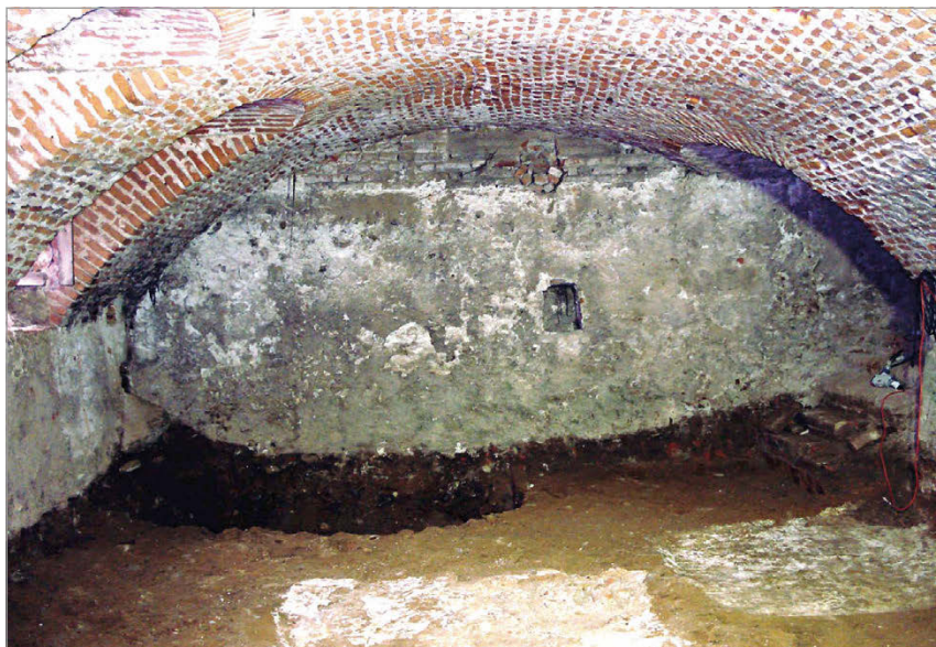
Fig. 21 – 2006-2007: vano interrato 2, da ovest.
