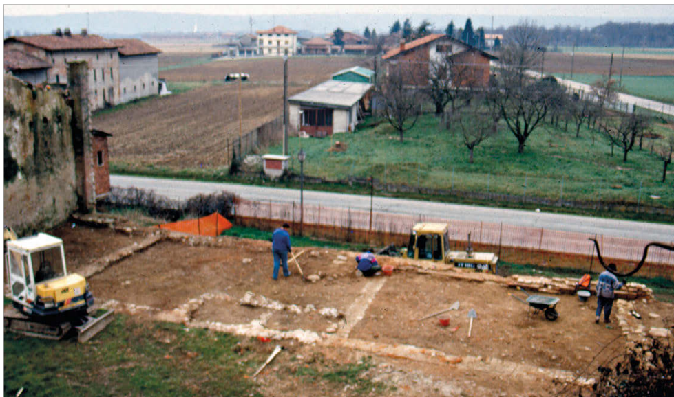
Fig. 13 – 2001, panoramica area di scavo ad avvio cantiere, da est.
