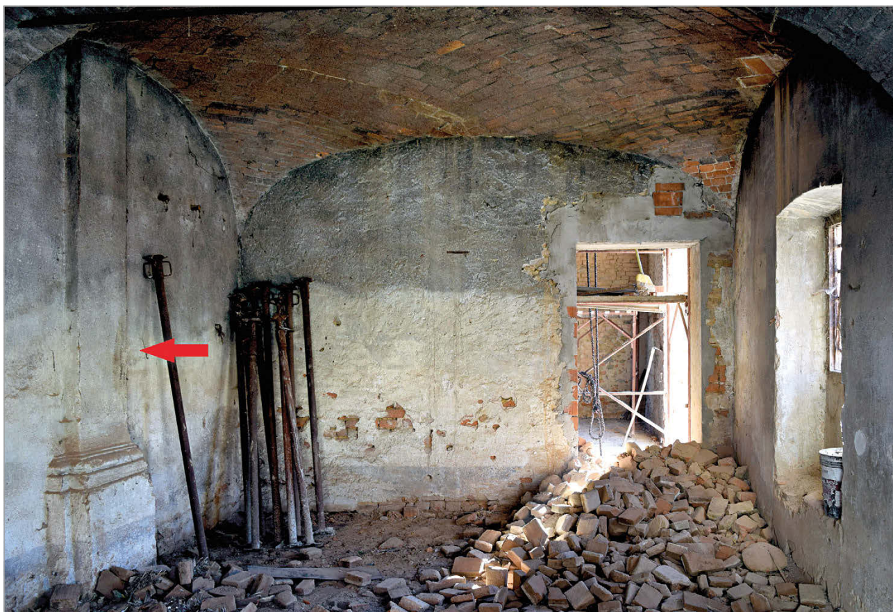
Fig. 57 – 2016: vano 12, da ovest.
