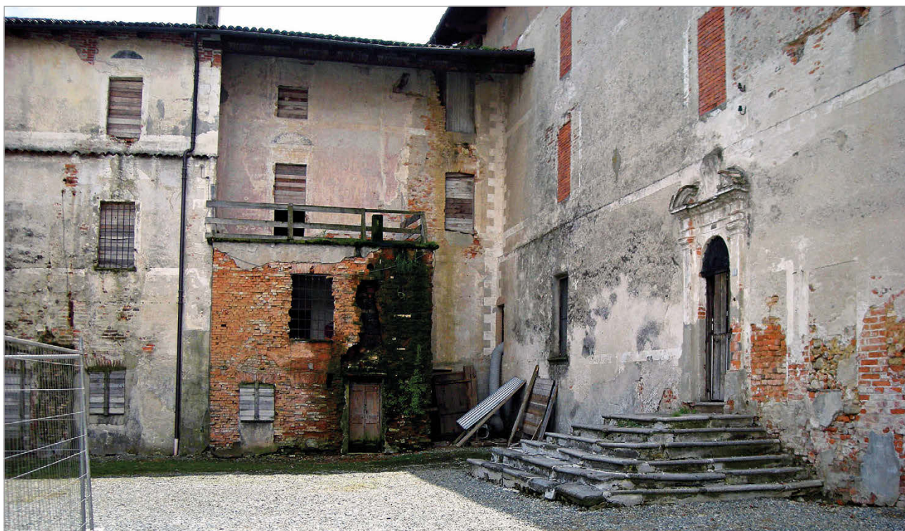
Fig. 41 – 2010-2011: cortile, cortile, la struttura addossata all'angolo sud-ovest, da nord, prima della demolizione.
