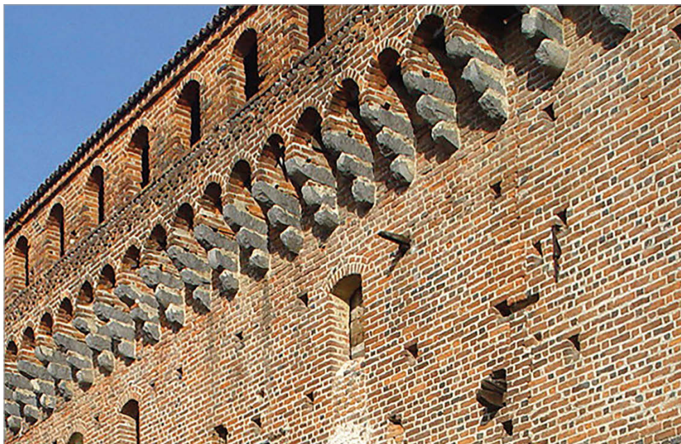
Fig. 8 – Dettaglio della serie di caditoie lungo il prospetto ovest del castello.
