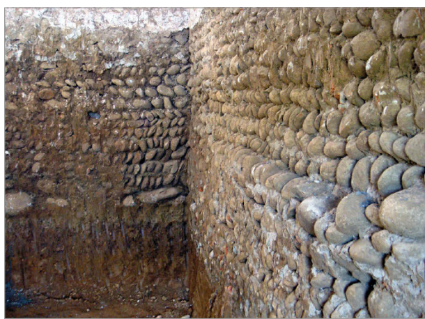
Fig. 38 – 2010-2011: vano 10, muratura est, da ovest.
