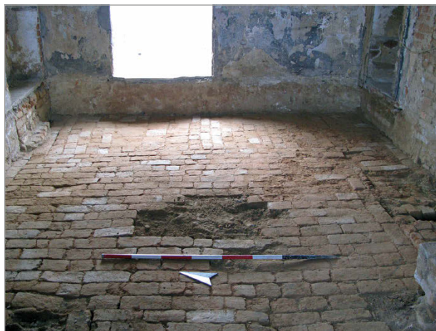
Fig. 37 – 2010-2011: vano 10, pavimento laterizio (US 105), da ovest.
