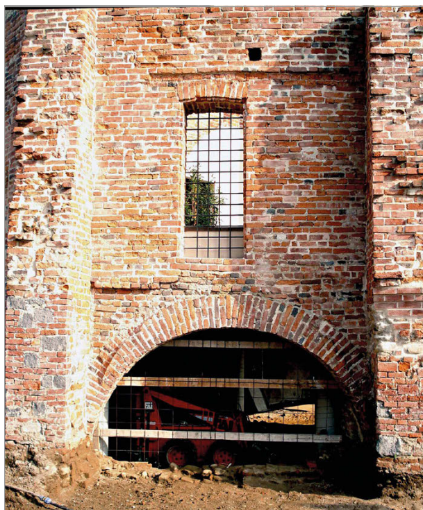
Fig. 26 – 2006-2007: angolo nord-ovest prima dello scavo.
