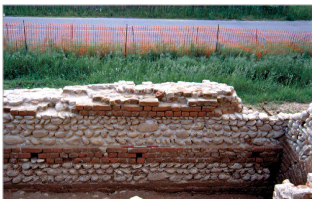
Fig. 17 – 2001, muratura 1A in corso di scavo.
