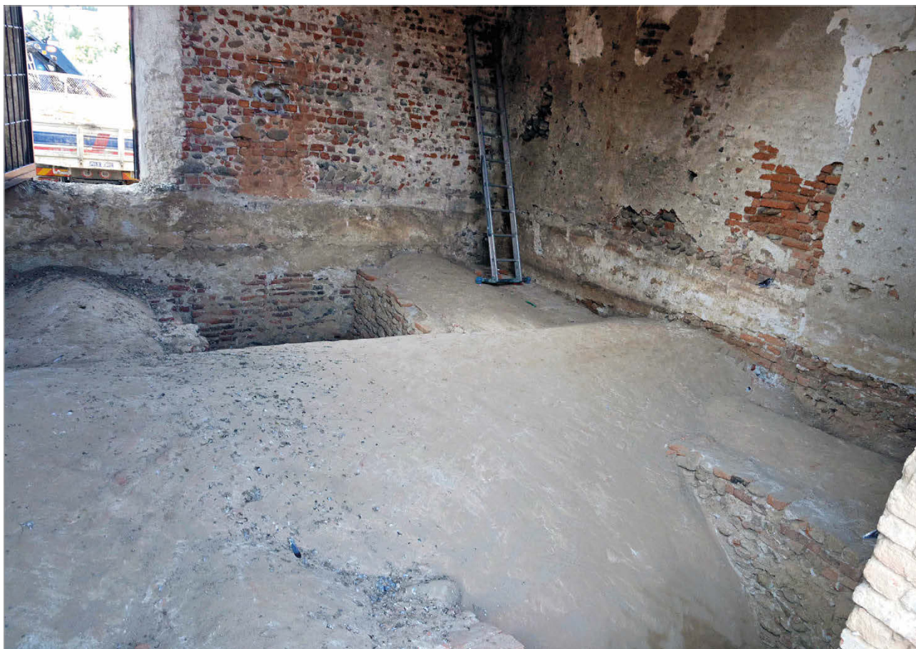
Fig. 58 – 2016: vano 13, volte, da sud-ovest.
