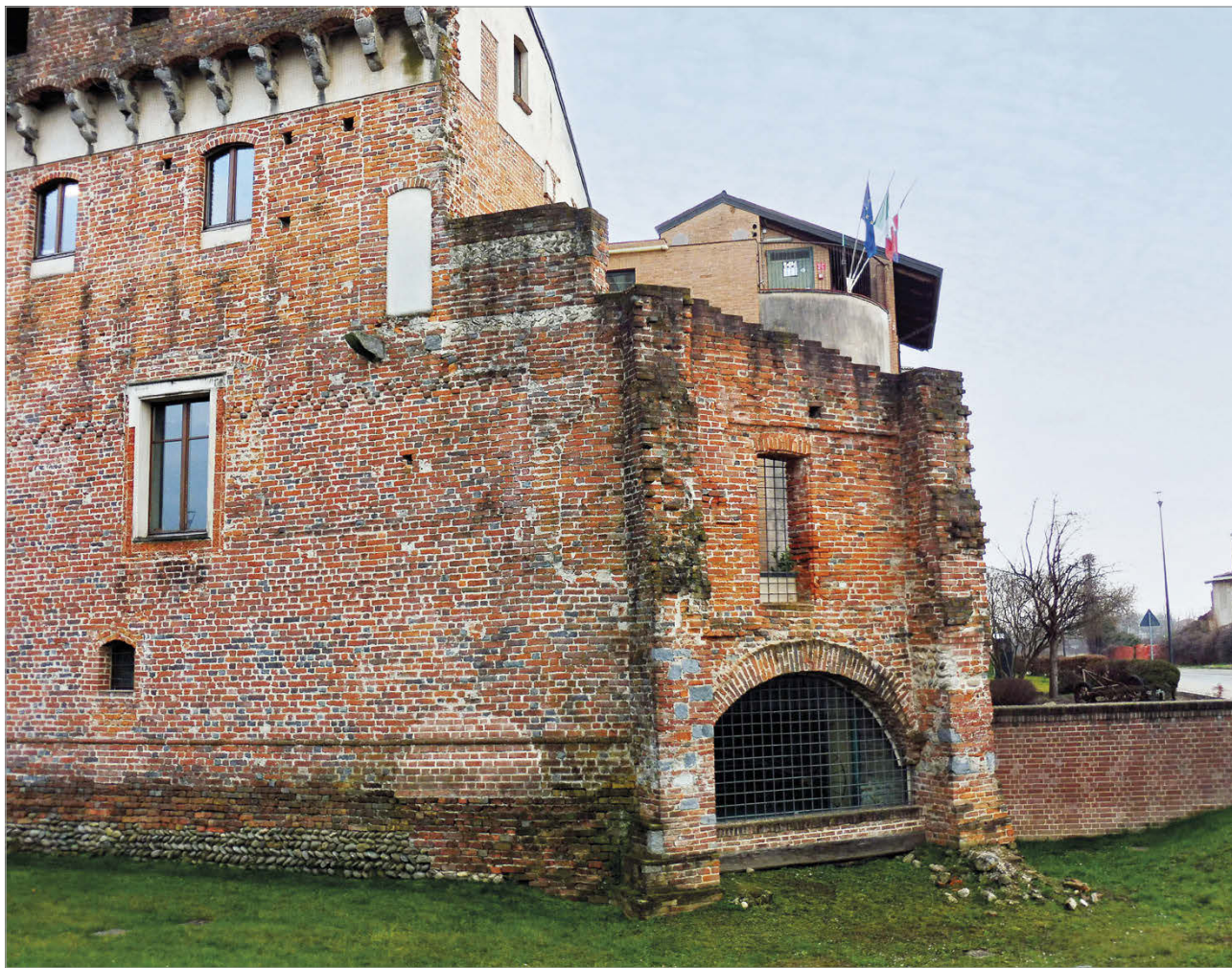
Fig. 166 – Angolo nord-ovest: monconi della distrutta torre angolare.
