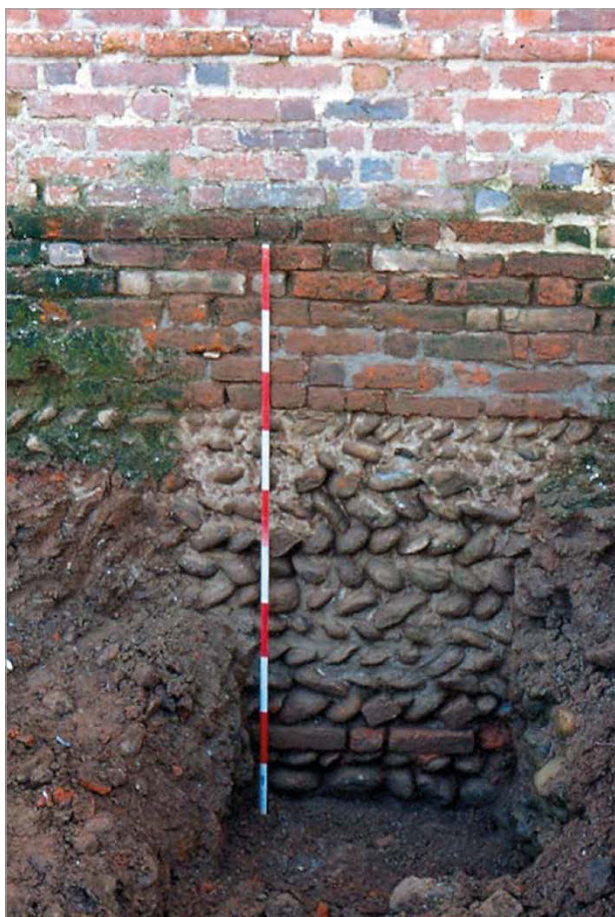
Fig. 24 – 2006-2007: particolare muratura, da nord.
