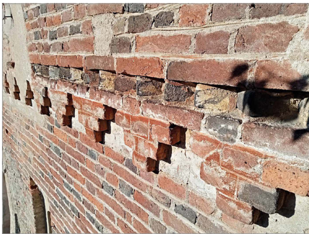
Fig. 10 – Dettaglio dell'apparato decorativo in mattoni scalari lungo il prospetto meridionale, con tracce di intonaco dipinto.
