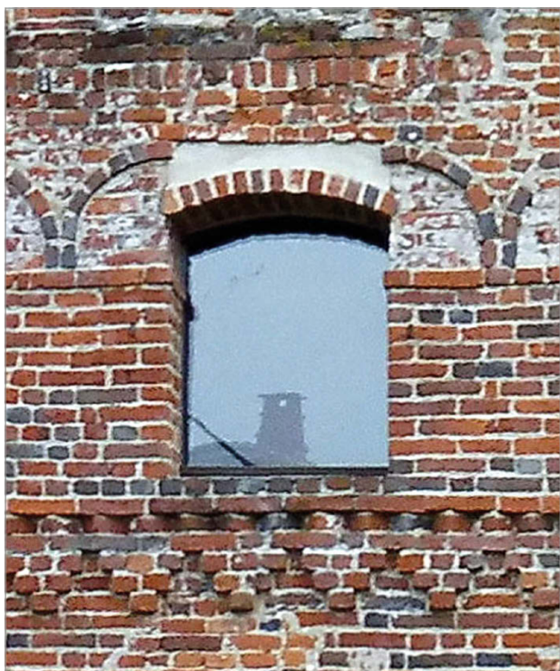
Fig. 150 – Prospetto nord: monofora realizzata nello spazio intermerlare.
