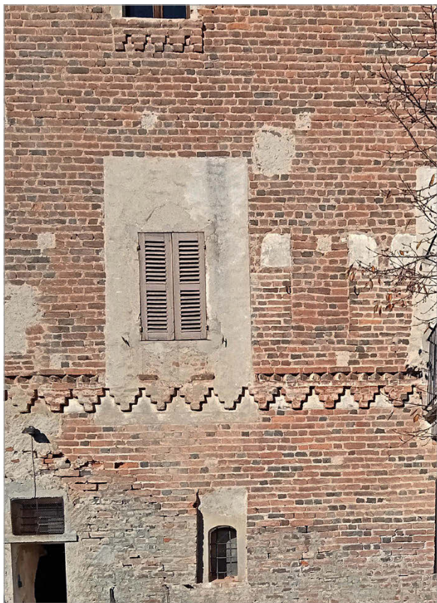
Fig. 11 – Resti di finestra ogivale, tamponata e successivamente rimpiazzata da un'apertura rettangolare, sul prospetto esterno meridionale del castello.
