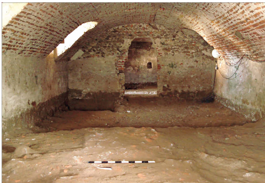
Fig. 22 – 2006-2007: vano interrato 1, da ovest.
