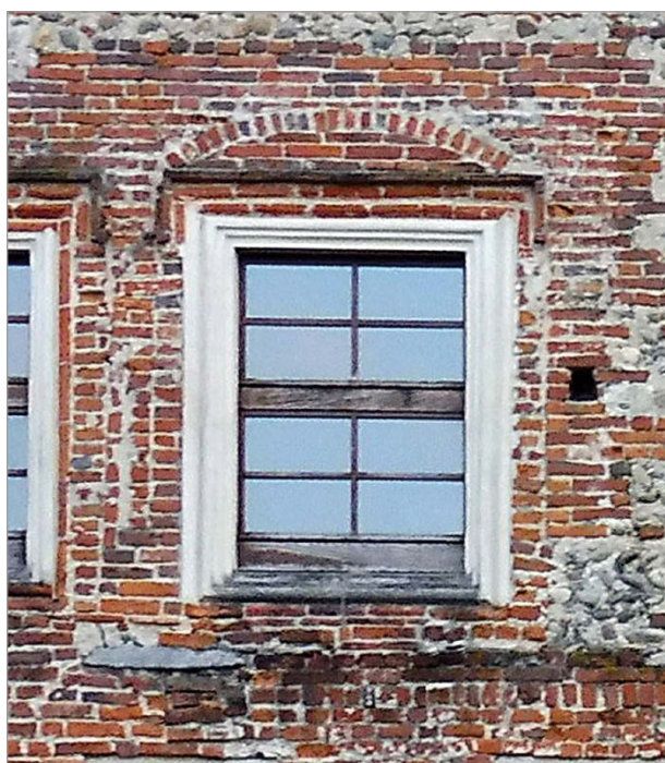
Fig. 153 – Prospetto nord: finestra con possibile articolazione originaria a crociera fittile.
