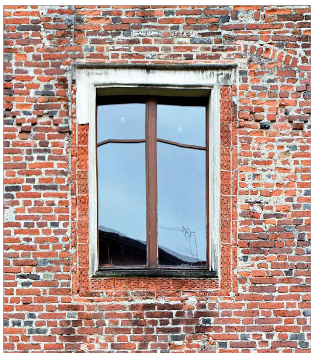
Fig. 152 – Prospetto nord: finestra con cornice a moduli decorativi fittili a motivi vegetali.
