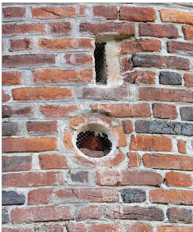
Fig. 159 – Torre angolare di sud-ovest: feritoia di mira.
