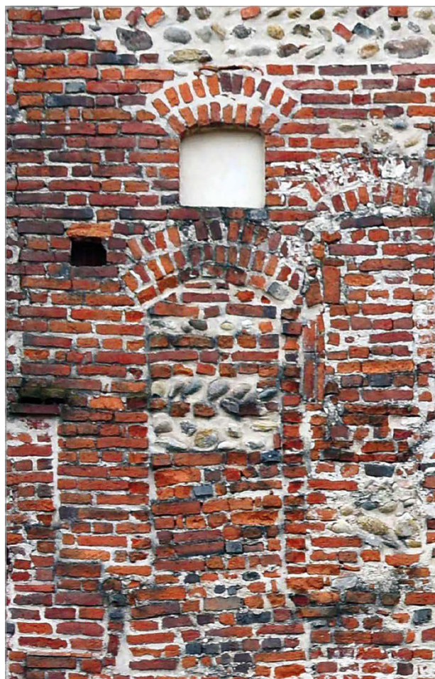
Fig. 165 – Prospetto nord: dettaglio di diverse monofore con ghiera laterizie.
