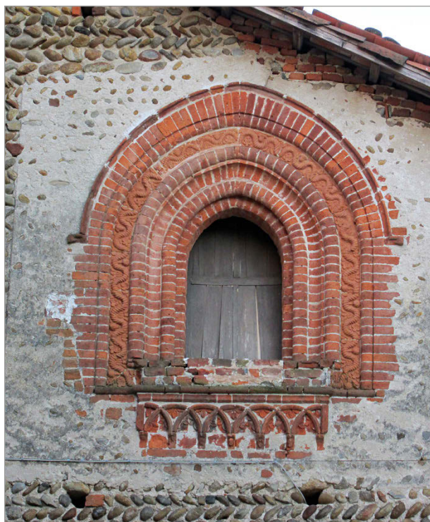
Fig. 151 – Castello di Massazza: esempio di finestra con profilo archiacuto e ornamentazione fittile a stampo.
