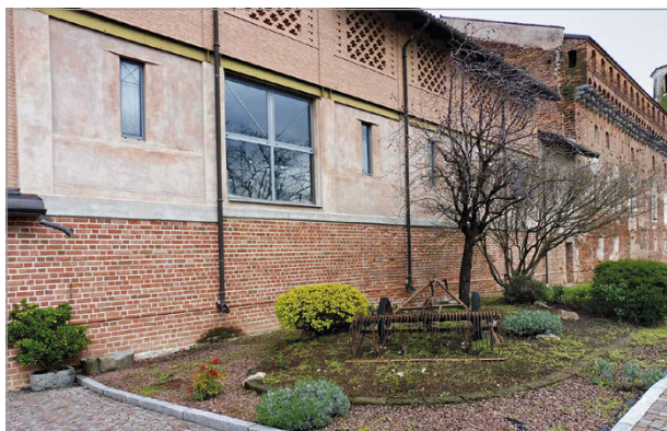
Fig. 20 – Muratura con foderatura laterizia e cornice torica oggi.
