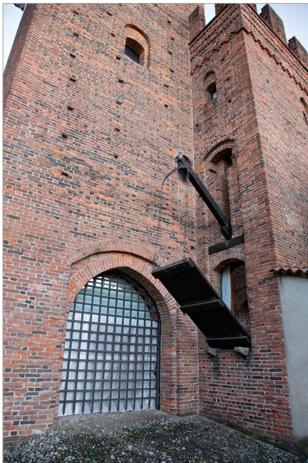
Fig. 5 – La ponticella levatoia sul perimetrale settentrionale del dongione.
