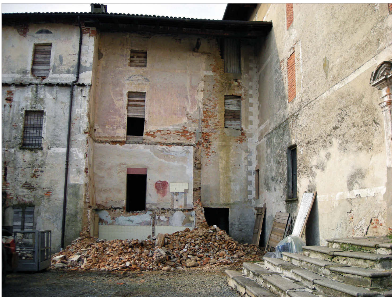
Fig. 42 – 2010-2011: cortile, angolo sud-ovest, da nord, dopo la demolizione.
