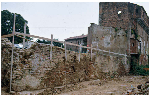
Fig. 19 – 2001, muratura con foderatura laterizia e cornice torica in corso di scavo.
