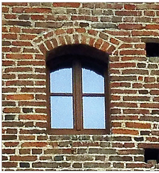
Fig. 149 – Prospetto nord: monofora con ghiera sormontata da laterizi in funzione di bardellone.
