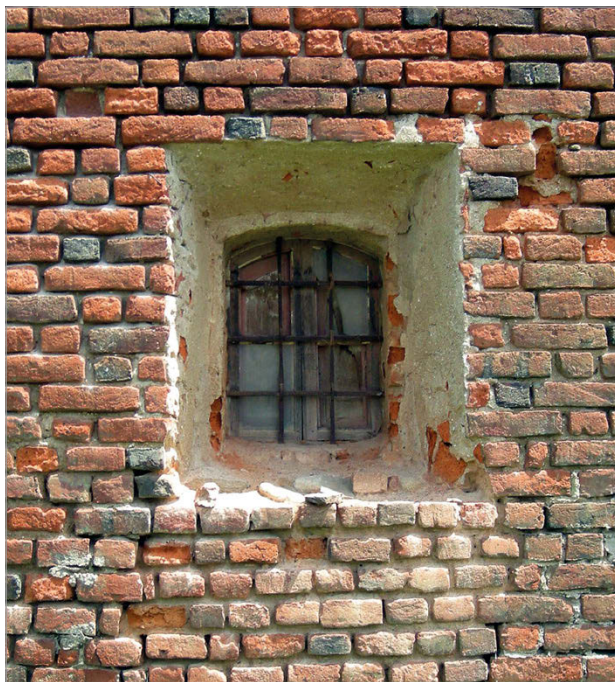
Fig. 146 – Prospetto nord: monofora con strombatura.
