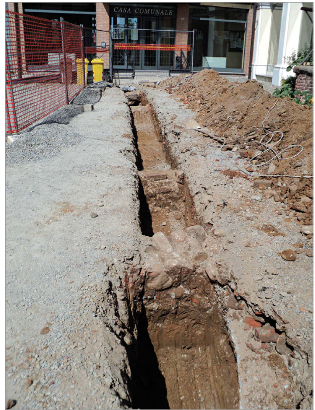
Fig. 53 – 2016: trincea cortile, da est.
