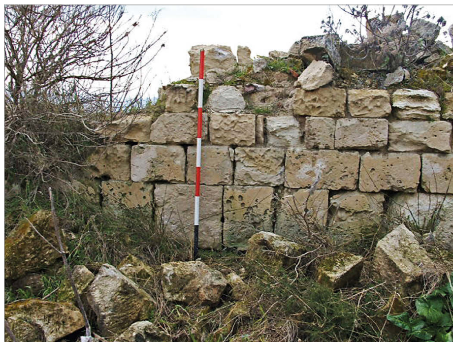
fig. 16 – San Giovanni Oppia (Mores, Sassari), muro perimetrale nord della chiesa di San Giovanni (febbraio 2005).
