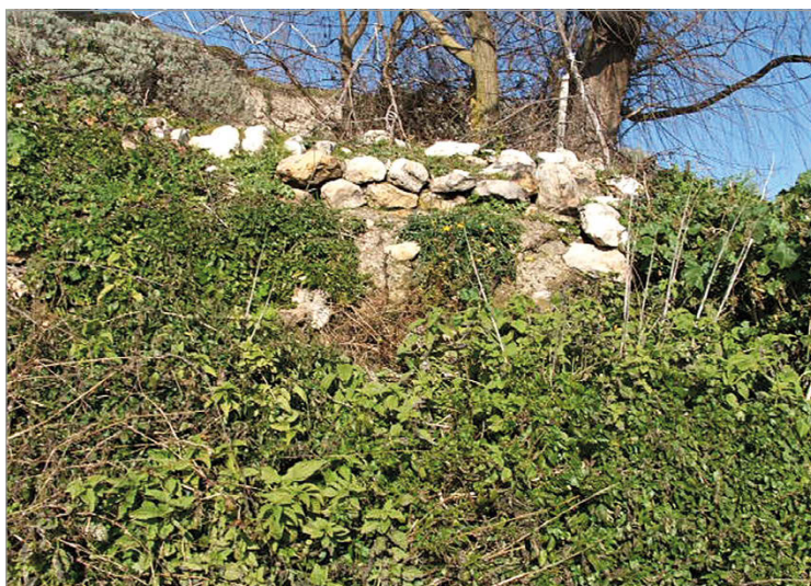
fig. 8 – Lachesos (Mores, Sassari), porzione di struttura muraria rasata e in parte crollata, pertinente a un edificio del villaggio (UT 10) (gennaio 2005).
