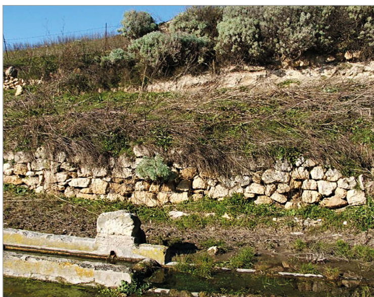
fig. 7 – Lachesos (Mores, Sassari), porzione di struttura muraria pertinente a un edificio del villaggio (UT 9) (gennaio 2005).
