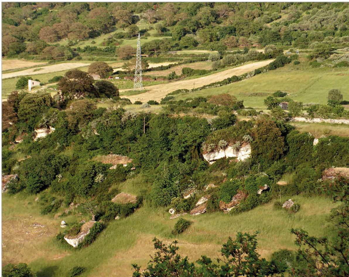
fig. 18 – S. Teodoro: panoramica del sito.
